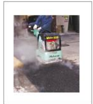
MVH-306DS アスファルト転圧
